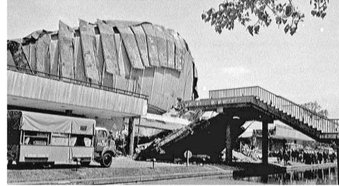
**Bild 1:** Kongresshalle Berlin (© Wikipedia) nach dem Wiederaufbau heute (links) und unmittelbar nach dem Einsturz der Dachkonstruktion 1980
