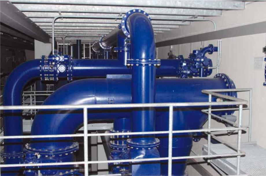
Durch teilweise 1,40 m dicke Rohre wird das geklärte Rheinwasser in einen Zwischenspeicher gepumpt.
