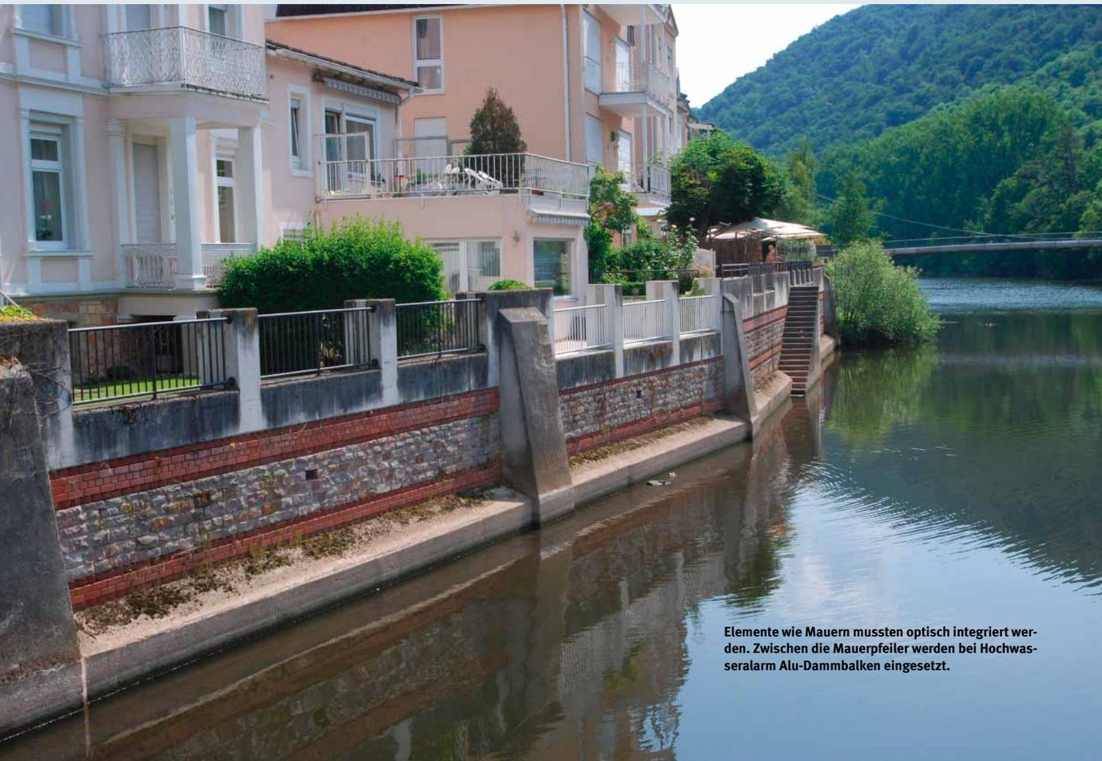
Elemente wie Mauern mussten optisch integriert werden. Zwischen die Mauerpfeiler werden bei Hochwasser Alu-Dammbalken eingesetzt.
